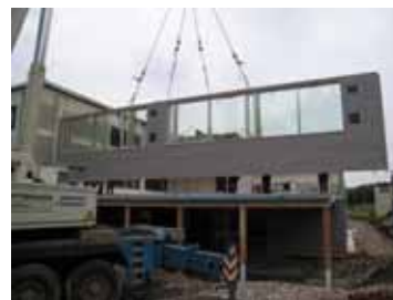
Přístavba k základní škole 2 – postup stavby v červenci 2006. Celá třípodlažní část budovy z dřevěných prefabrikovaných dílců byla vybudována během 4 dnů včetně fasády, oken a izolované střechy.
