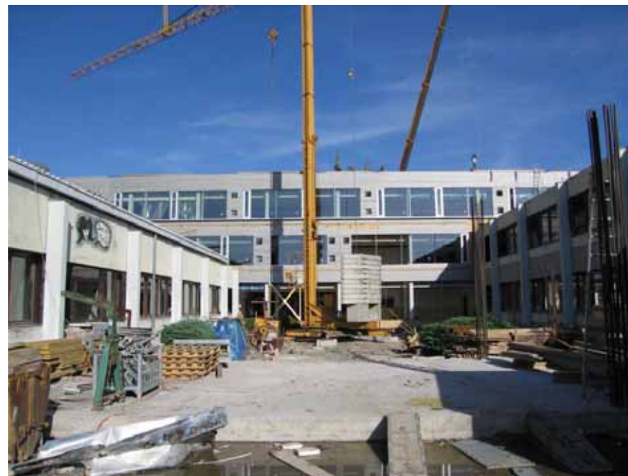
Na západě před výstavbou nového schodiště polytechnické školy
