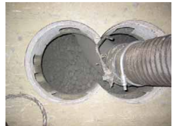
První foukání pěnového skla pod stávající podlahovou desku v dubnu 2005
