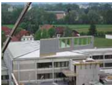
Přístavba k základní škole 2 – postup stavby v červenci 2006. Celá třípodlažní část budovy z dřevěných prefabrikovaných dílců byla vybudována během 4 dnů včetně fasády, oken a izolované střechy.
