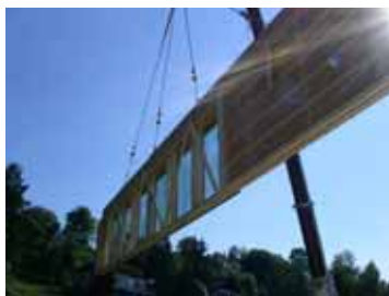
Přístavba k základní škole 2 – postup stavby v červenci 2006. Celá třípodlažní část budovy z dřevěných prefabrikovaných dílců byla vybudována během 4 dnů včetně fasády, oken a izolované střechy.
