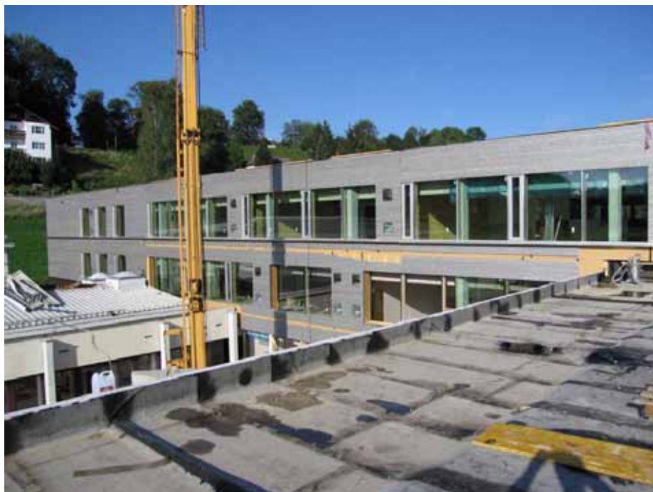
Montáž 6 dílců na dvoře mezi školami
