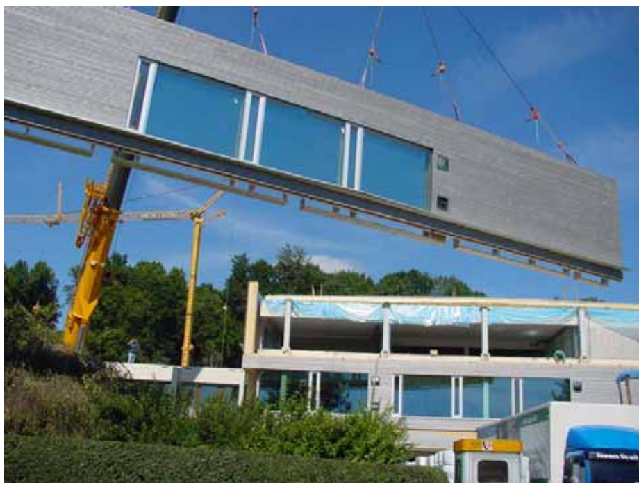
Montáž východní fasády
