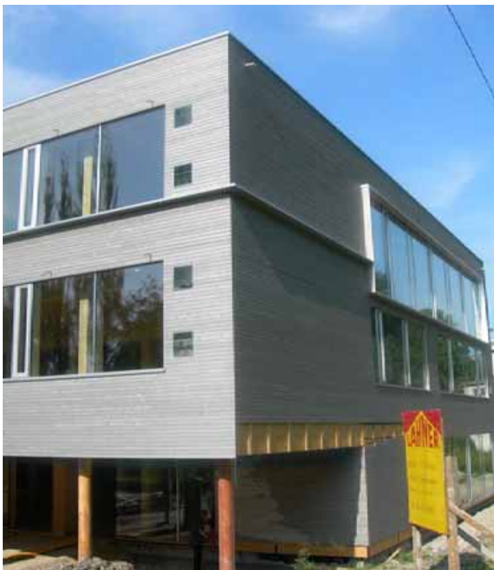
Přístavba k základní škole 2 – postup stavby v červenci 2006. Celá třípodlažní část budovy z dřevěných prefabrikovaných dílců byla vybudována během 4 dnů včetně fasády, oken a izolované střechy.
