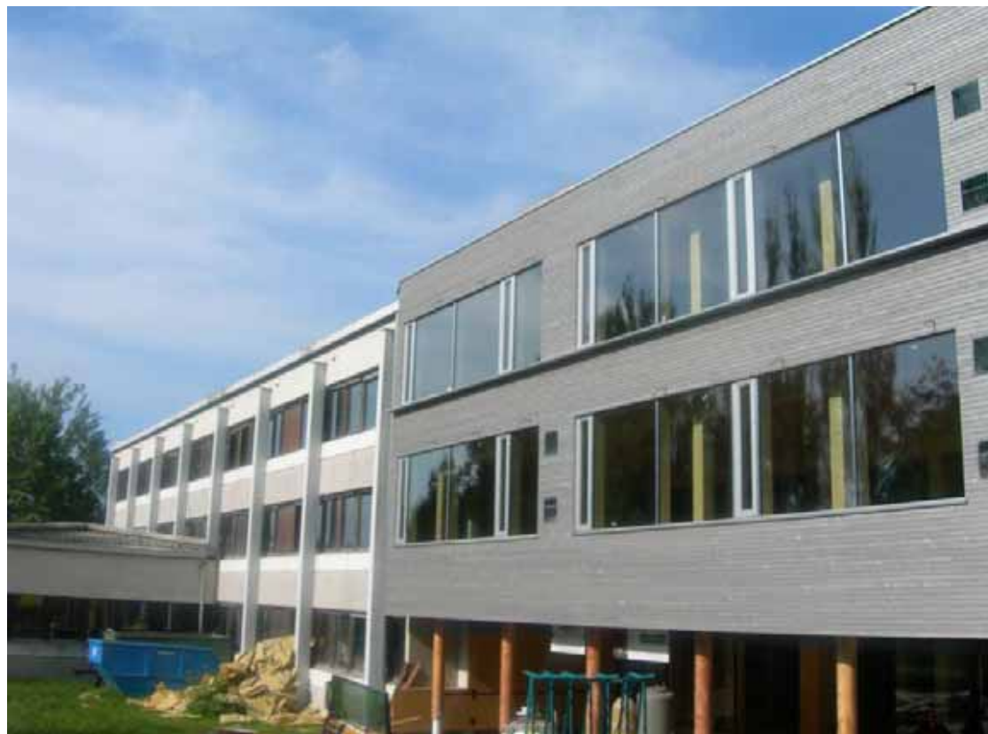
Přístavba k základní škole 2 – postup stavby v červenci 2006. Celá třípodlažní část budovy z dřevěných prefabrikovaných dílců byla vybudována během 4 dnů včetně fasády, oken a izolované střechy.
