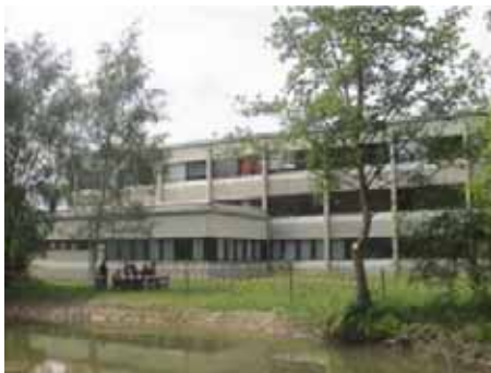
Původní stav z roku 2005
