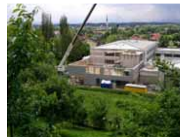
Přístavba k základní škole 2 – postup stavby v červenci 2006. Celá třípodlažní část budovy z dřevěných prefabrikovaných dílců byla vybudována během 4 dnů včetně fasády, oken a izolované střechy.
